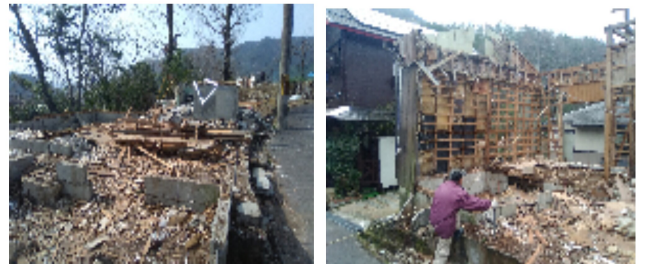
危険な廃屋を解体
