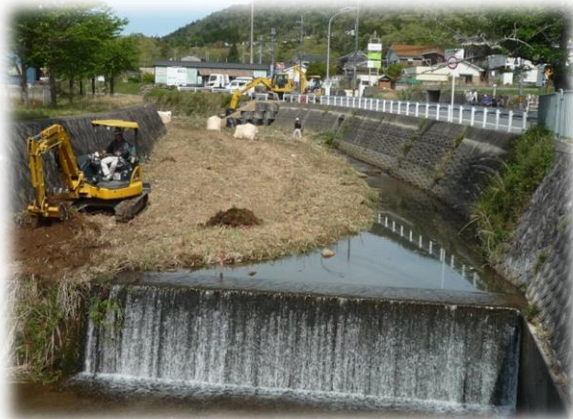
（河川に重機が入って浚渫）
