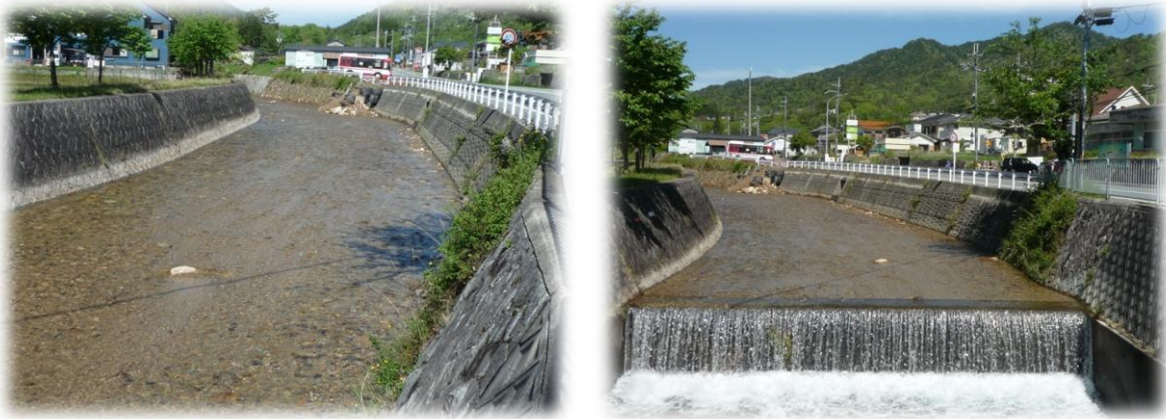
（浚渫が完了し綺麗になった大路次川）
