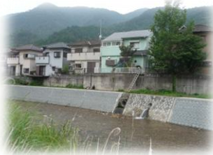
大路次川の復旧工事
