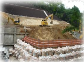
府道の復旧工事
