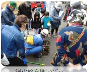
消火栓を開いて…
