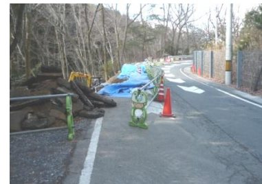
(府道54号/路肩崩落の復旧工事)
