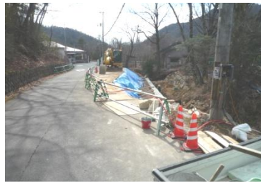
(普通河川 砂川/護岸の復旧工事)
