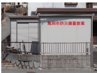
（高橋に設置の防災備蓄倉庫）
