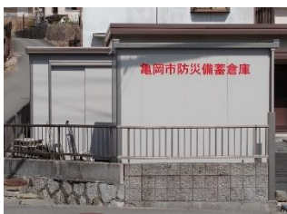
(高橋に設置の防災備蓄倉庫)
