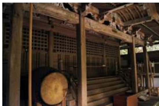
(四間社の本殿内部)
